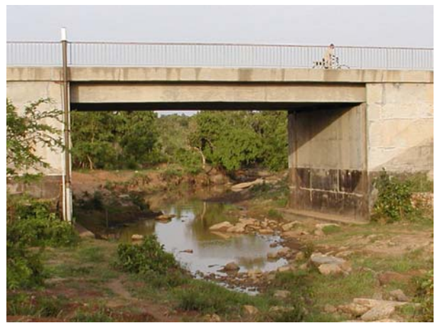
Photo 12 : Vue de l'exutoire du bassin versant.
