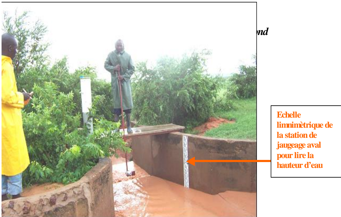
Photo 5: Prélèvements d'échantillons pour l'estimation de la charge de fond à la station aval de Tondi Kiboro, à droite de la photo7, l' échelle limnimétrique de la station (Photos: MAMADOU IBRAHIM Banizoumbou Août 2004)
