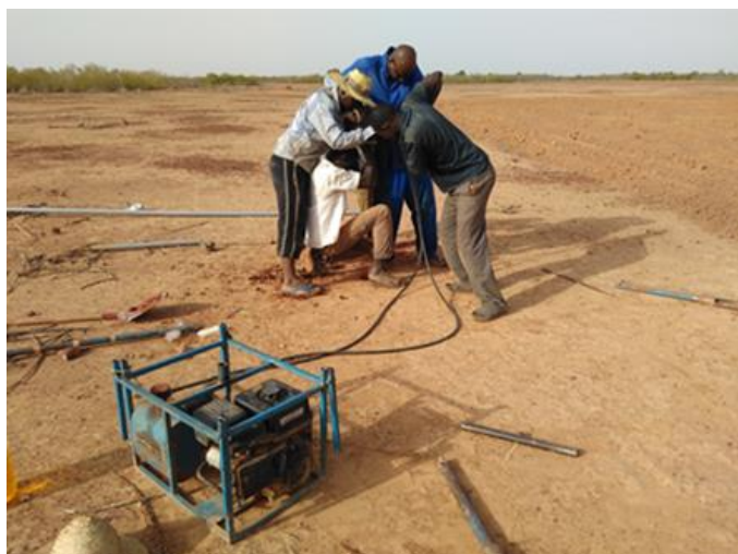
Figure 3.2. Installation des tubes d'humidité à l'aide d'une tarière motorisée.
