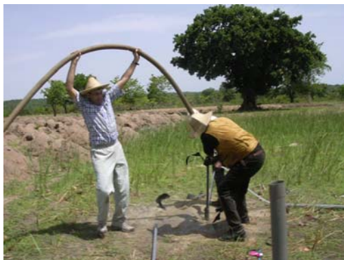
c et d : Air comprimé injecté pour essayer de retirer la pompe puis essai avec une tige métallique mais sans succès
