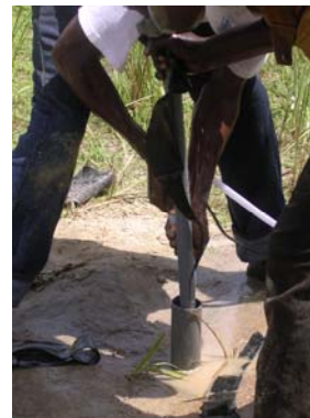
c et d : Air comprimé injecté pour essayer de retirer la pompe puis essai avec une tige métallique mais sans succès
