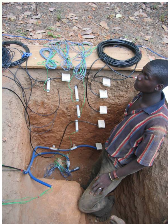
Fosse ouverte des capteurs d'humidité CS616, des Water mark pour la succion et des capteurs thermocouple pour la température
